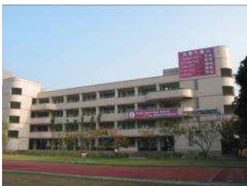
改制完全中學的第 1 棟高中大樓（綜高大樓）89 年 5 月落成
